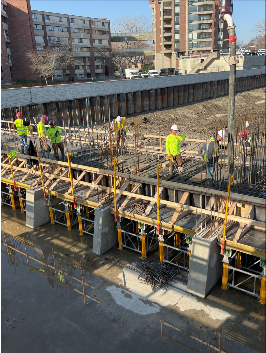
Figure 12 – Gate Slab Pour (elevation 575)
