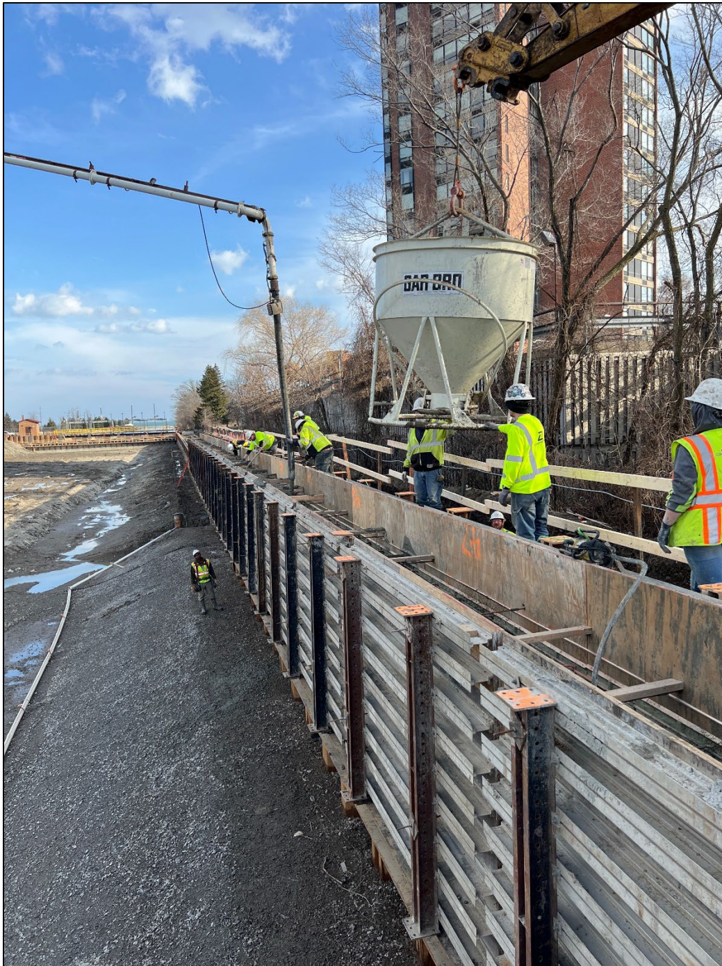
Figure 16 – South Side concrete cap pour
