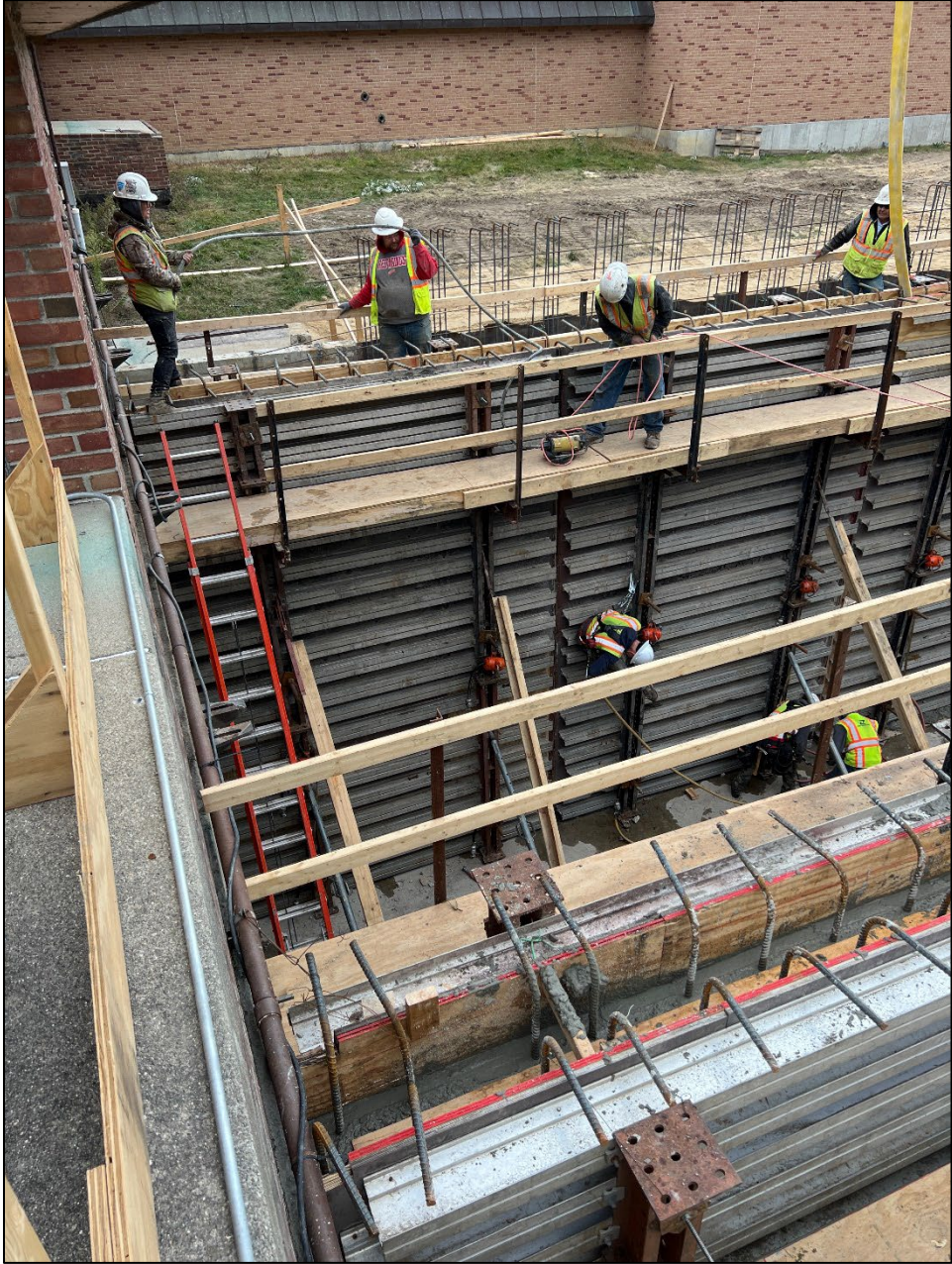
Figure 14 – Divider wall pour
